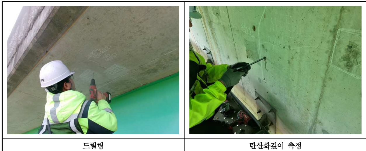
【사진 21.4.3】 탄산화 깊이 측정 현장사진
