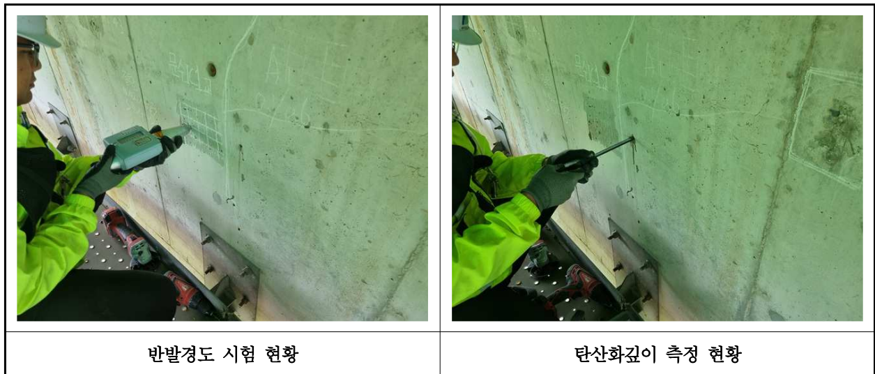
【사진 21.4.1】 콘크리트 내구성조사 현황
