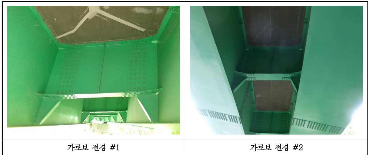
【사진 21.3.6】 가로보 전경
