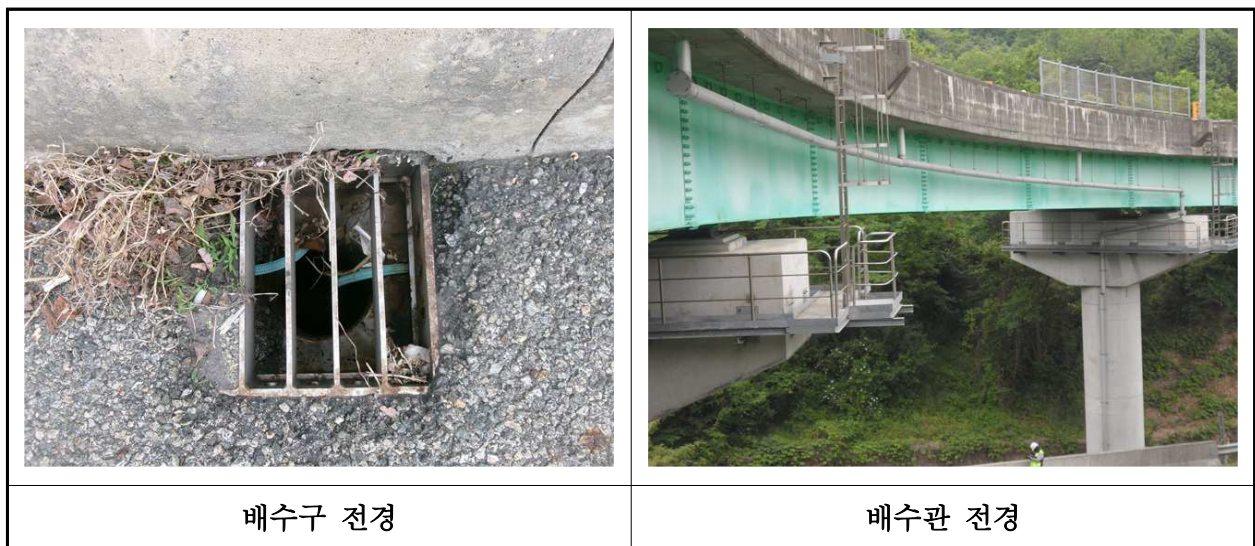
【사진 21.3.22】 배수시설 전경
