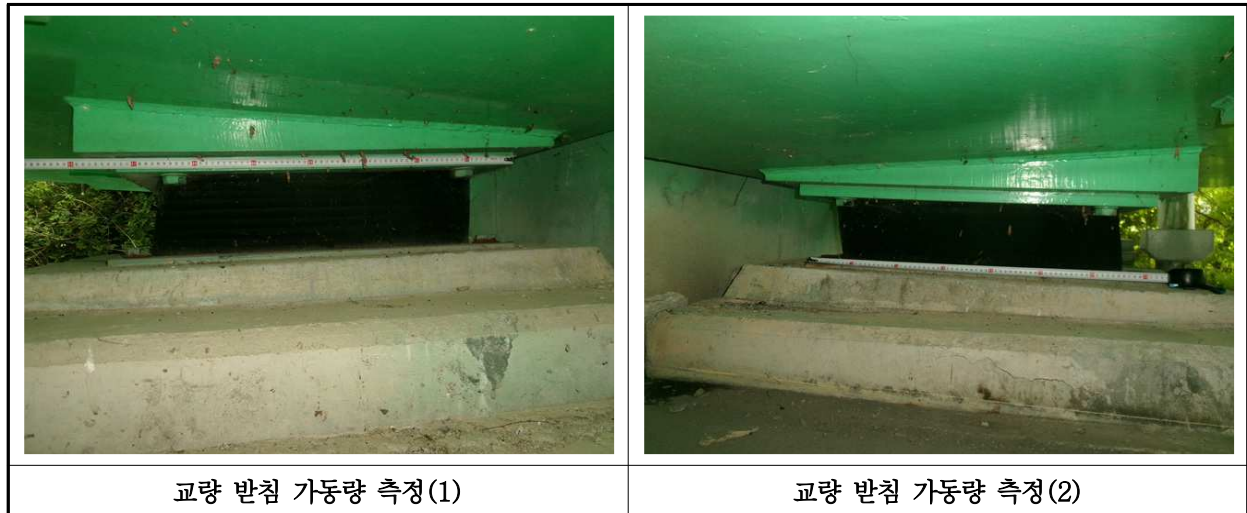
【사진 21.3.16】 교량받침 이동량 측정
